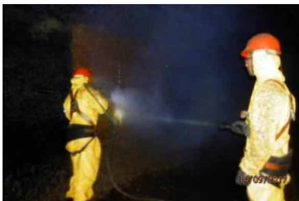
Figura 14. Remoção da bioincrustação nas galerias e túnel mediante utilização da hidro-jateamento a 27.000 psi.
