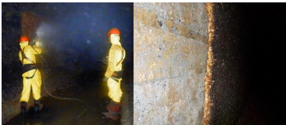
Figura 51 - Hidrojateamento utilizando pressão de 27.000 psi com a pistola do equipamento de hidrojato posicionada a 45^\circ com a superfície da estrutura.
