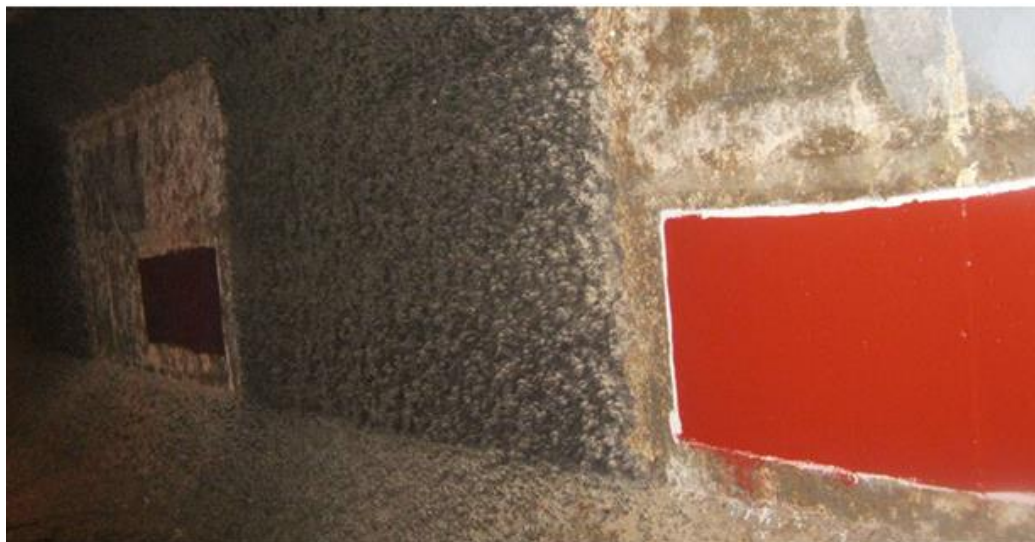
Figura 50 - Remoção amostral da bioincrustação para inspeção parcial da estrutura.
