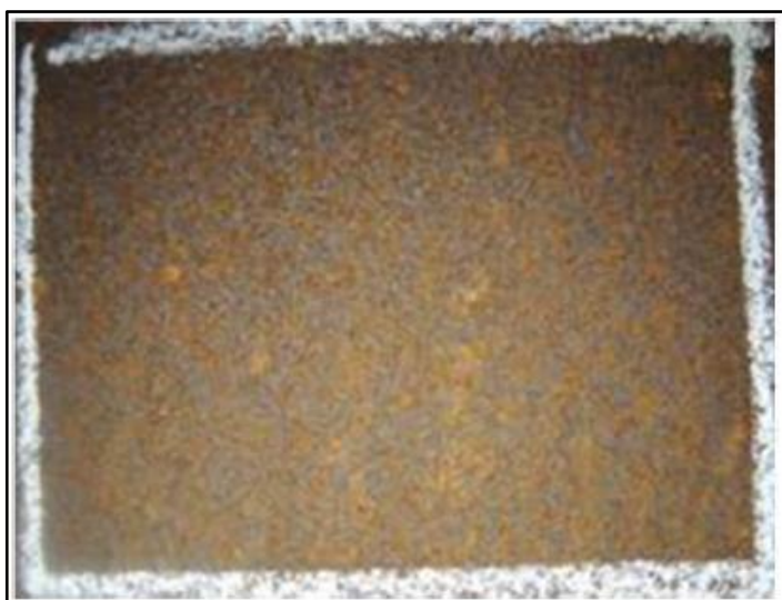
Figura 5. Detalhe de uma camada de pátina em uma superfície
