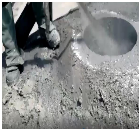
Aplicação do concreto
