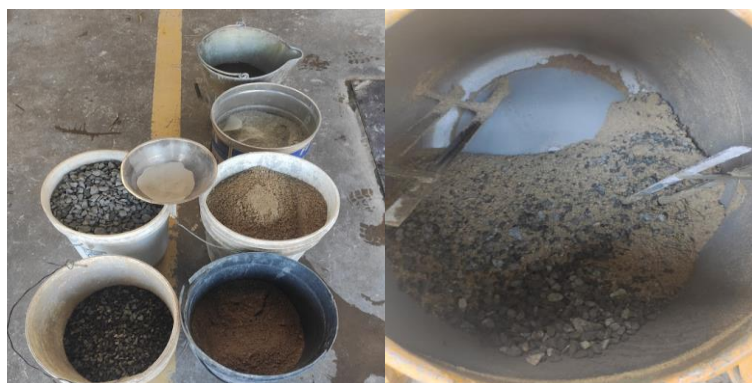
Figura 4. Traços do concreto separados e na betoneira.
