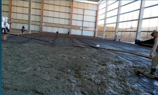
Concretagem utilizando macrofibra sintética
