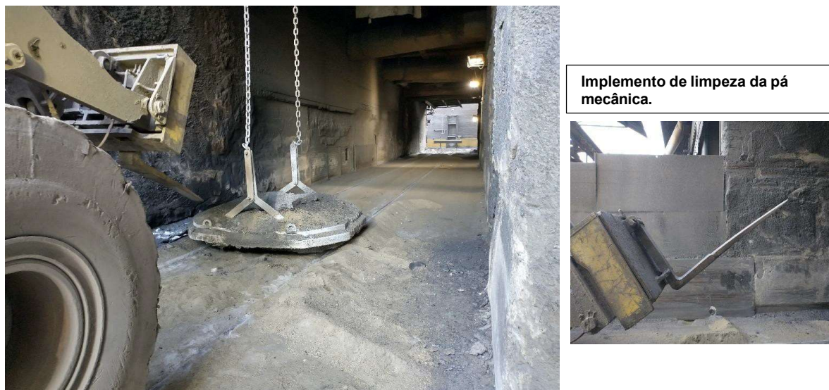
Figura 26. Limpeza da tampa com pá mecânica
