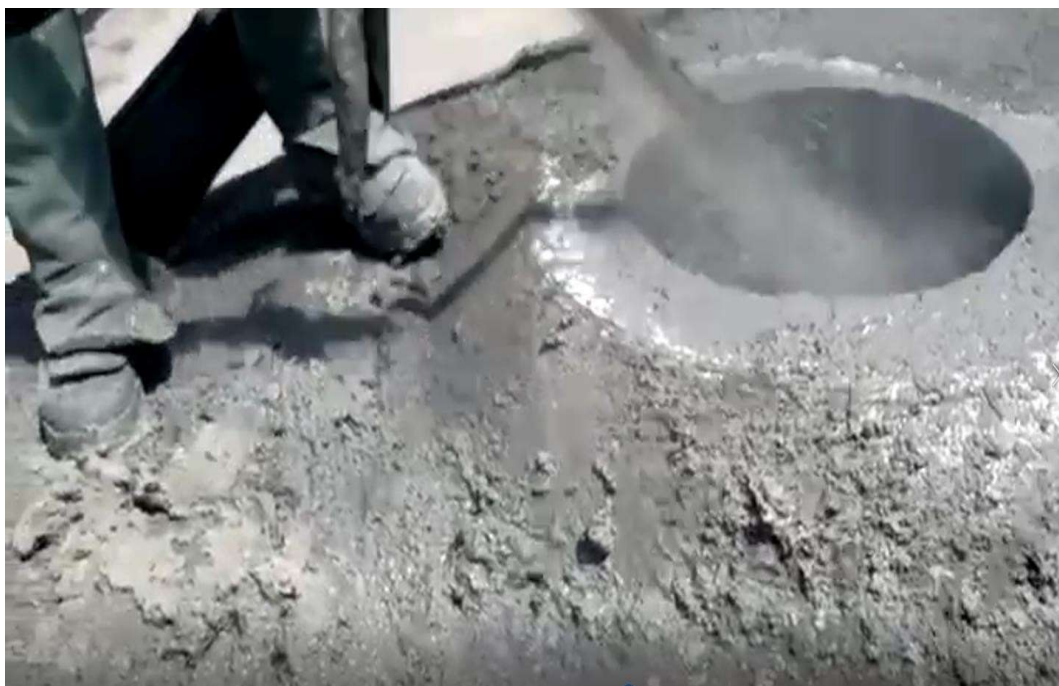
Figura 24. Aplicação do concreto refratário pelo método gunning
