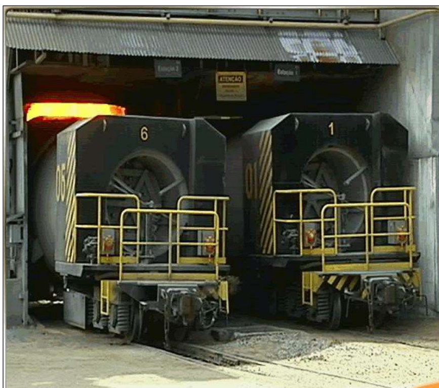
Figura 8. Estação de dessulfuração de gusa
