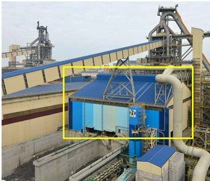
Figura 4. Casa dos silos
