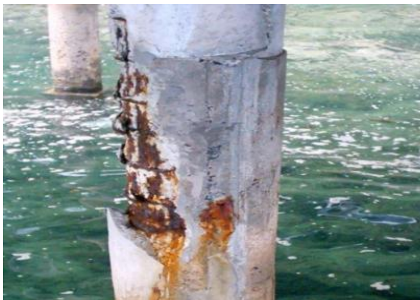
Figura 2: Ilustração de degradação do concreto por cloretos
