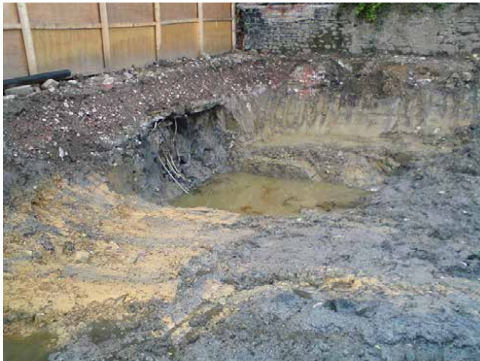
Contaminação do solo provocada pelo rompimento de tanques subterrâneos. Foto: Dumelow. Imagem retirada de: http://commons.wikimedia.org
