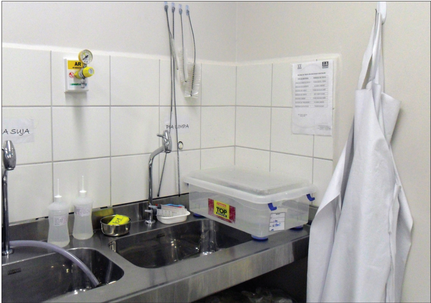
Figura 2: Área do expurgo
