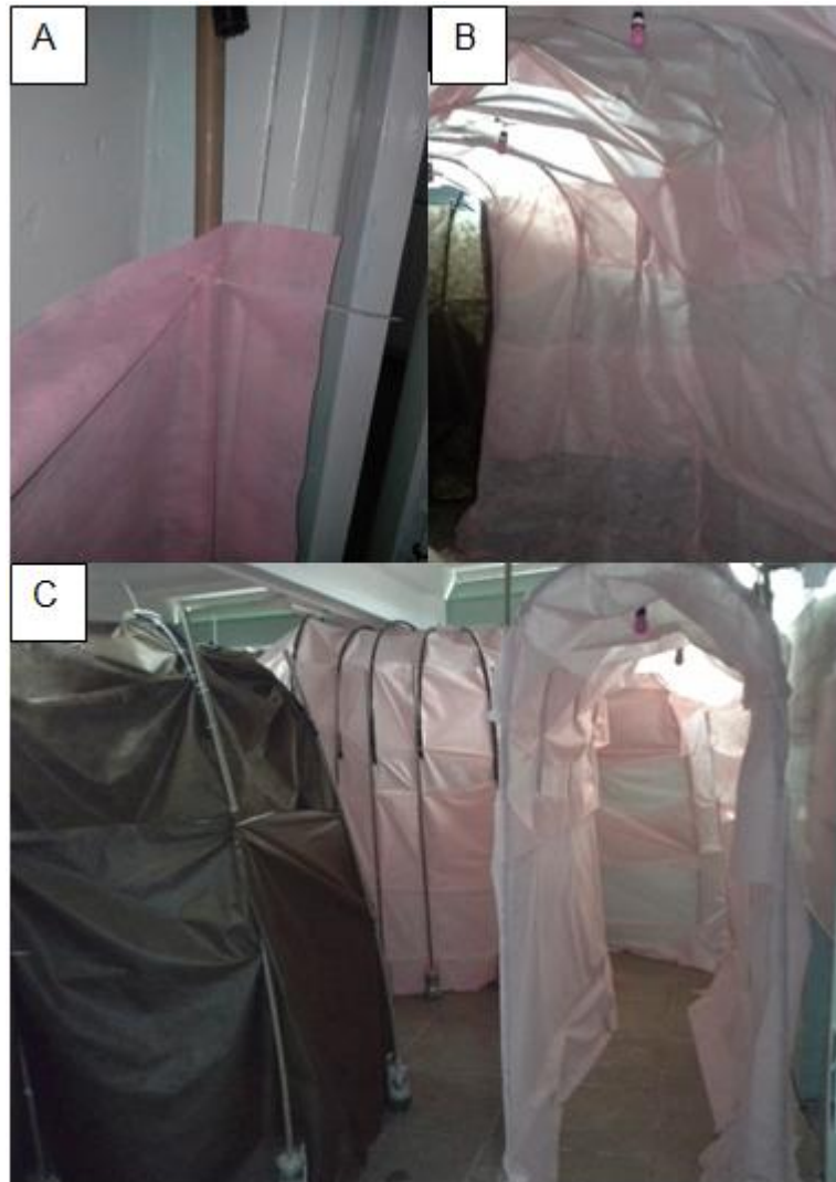
Figura 8 – Revestimento dos túneis
