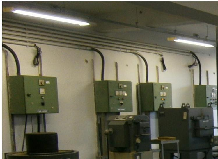
Figura 5.1 – Foto do painel de acionamento dos fornos (Fonte: o autor)
