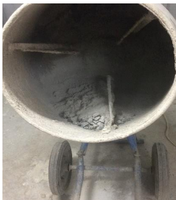
Figura 30 - Mistura do concreto na betoneira
