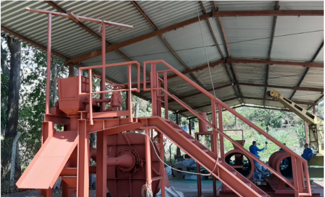
Figura 32: Plataforma com rampa para descarga da mistura sinterizada
