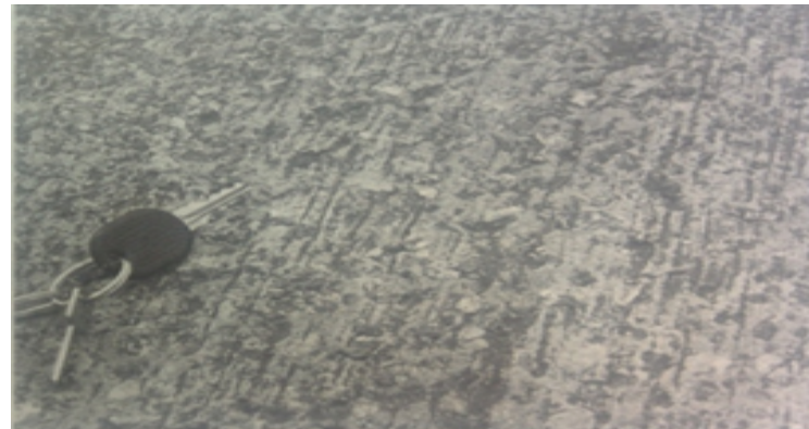
Esquerda - Abrasão inicial e formação de lamelas por exsudação do concreto; Direita - Desgaste da argamassa na superfície do pavimento de concreto, com exposição dos agregados
