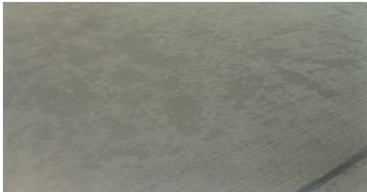
Esquerda - Abrasão inicial e formação de lamelas por exsudação do concreto; Direita - Desgaste da argamassa na superfície do pavimento de concreto, com exposição dos agregados
