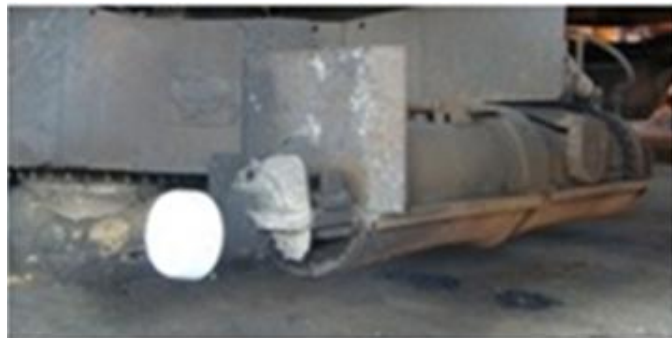
Máquina de injeção de massa com a proteção cerâmica montada.
