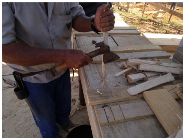
Figura 7. Obtenção das lascas de pau de escoramento (Fonte: Autoria própria)
