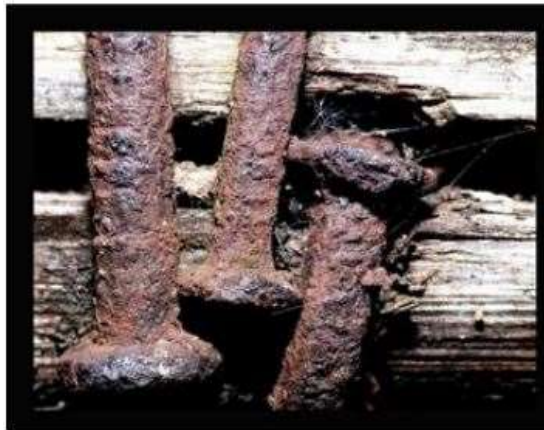
Figura 6 - Corrosão uniforme
