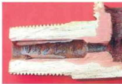
Figura 13 - Corrosão por dezincificação em latão
