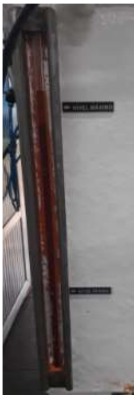
Figura 33. Visor de nível de óleo [Fonte: autor]
