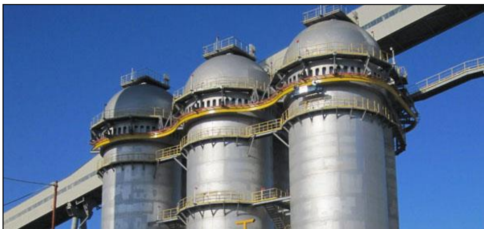
Figura 4 – Regeneradores de altos fornos
