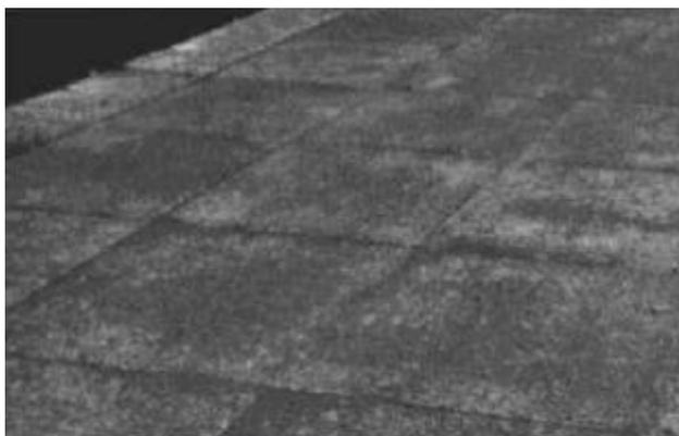
Figura 9: Placas de concreto permeável
