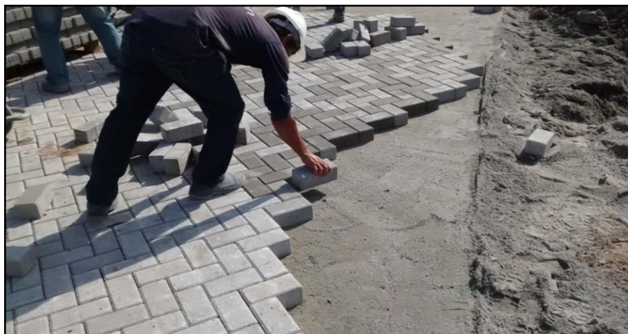
Figura 9: Etapa de assentamento dos blocos paver de concreto shopping Outlet Premium no município de Duque de Caxias - RJ.
