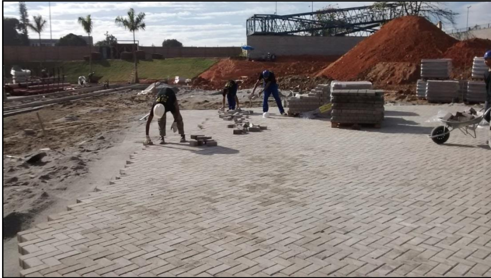
Figura 6: Pavimento de paver de concreto em execução no shopping Outlet Premium no município de Duque de Caxias – RJ
