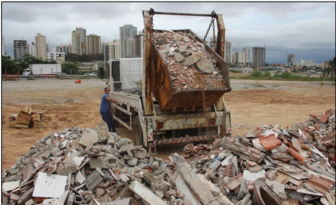
Figura 2: Resíduo de construção civil descartado inadequadamente em via pública. Barra da Tijuca – RJ
