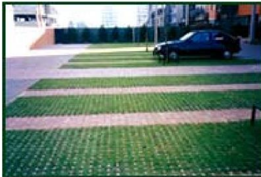
Figura 11: Pavimentação com blocos vazados de concreto
