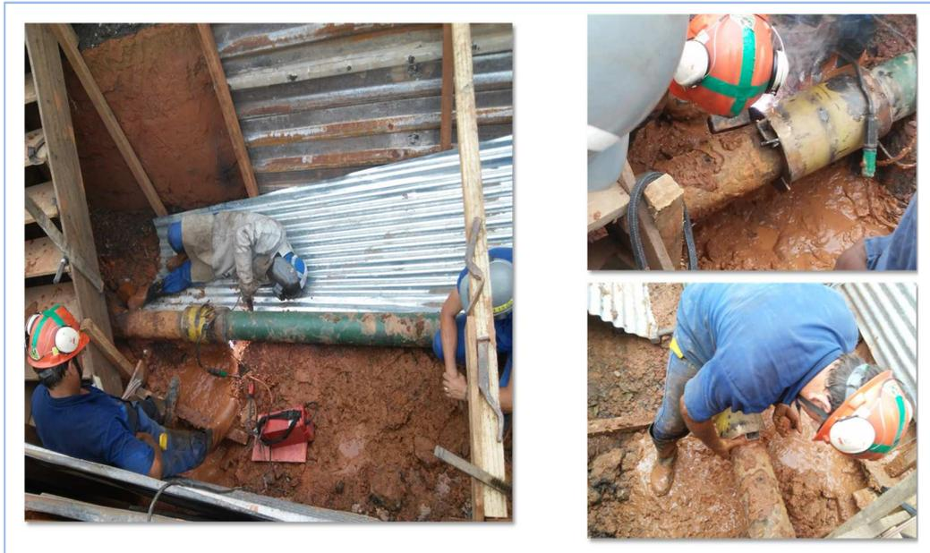
Figura 3: Montagem da bolsa nas tubulações.
