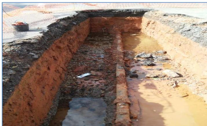
Figura 1: Tubulação em ferro fundido enterrada e rompida.
