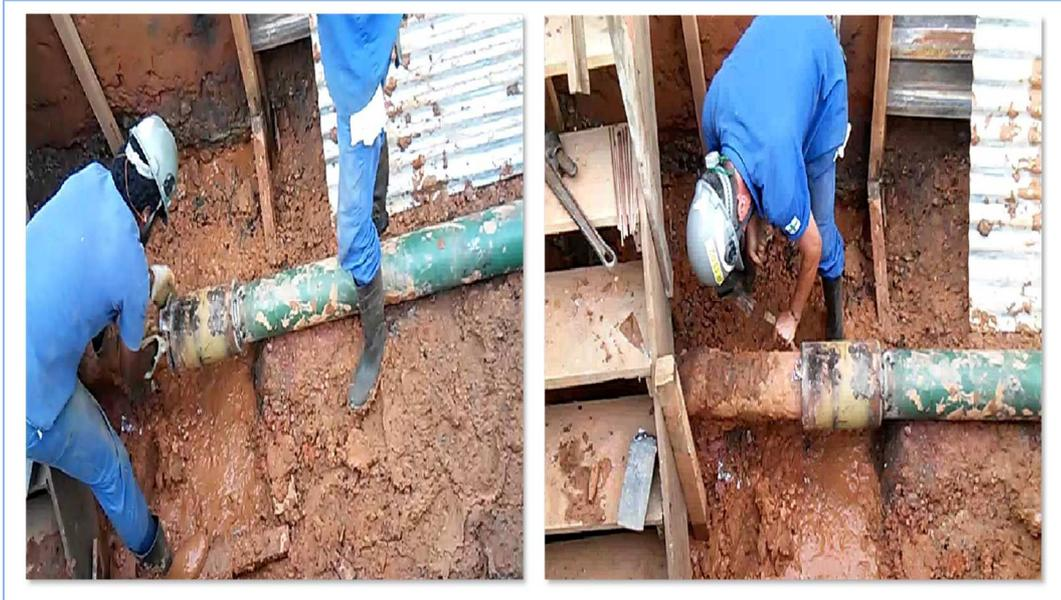
Figura 5: Rebatimento do chumbo derretido na bolsa.
