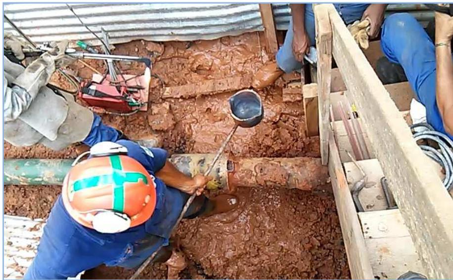
Figura 4: Inserção de chumbo derretido na bolsa.
