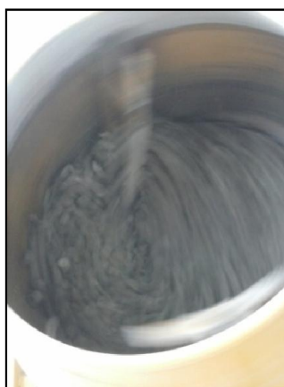
Fotografia 29 - Mistura do concreto na betoneira
