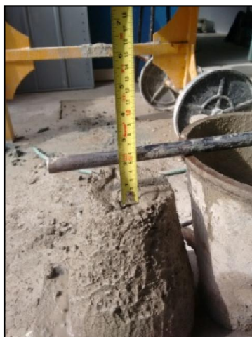
Fotografia 31- Teste de Slump - Aferição do abatimento
